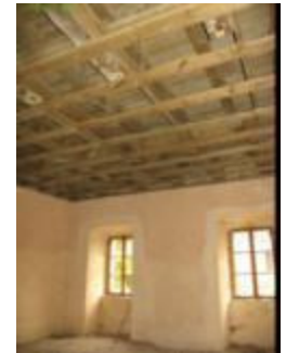
dřevěné stropy 1 kN/m 2
